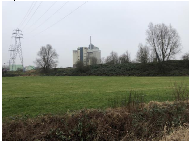
Bovenste_polder_west_4.jpg (foto locatie 28)
